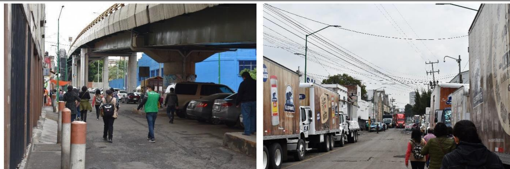
Ilustración 94 Condición actual de bajo puente / Calle obstruida por camiones de carga estacionados
