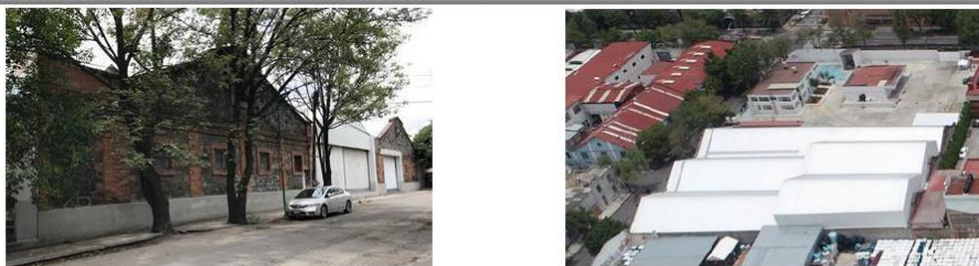
Ilustración 53 Inmueble en Fresno No. 376, Lote b: vista hacia calle Fresno / vista aérea.
