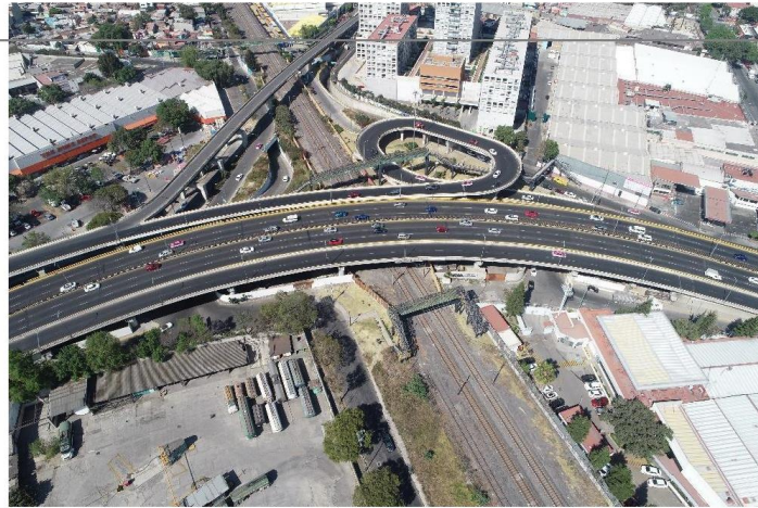
Ilustración 98 Cruce peatonal entre Av. Río Consulado y vías de tren suburbano
