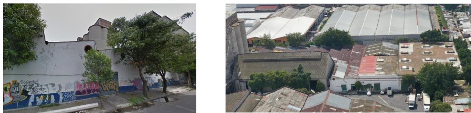
Ilustración 69 Pino No. 328: Instalaciones fabriles
