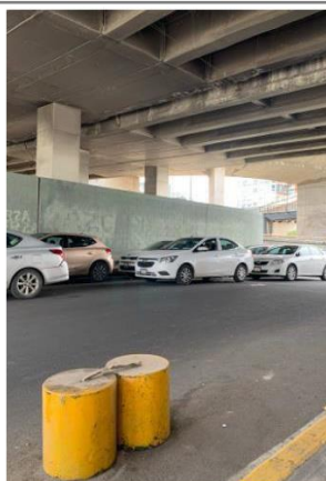
Bajo puente. Cto. Interior
