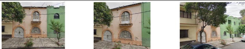
Ilustración 81 Lirio No. 13: Inmueble habitacional.
