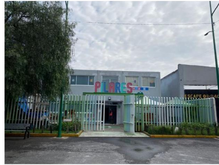
Pilares "Atlampa" ubicado en la calle Cedro 561
