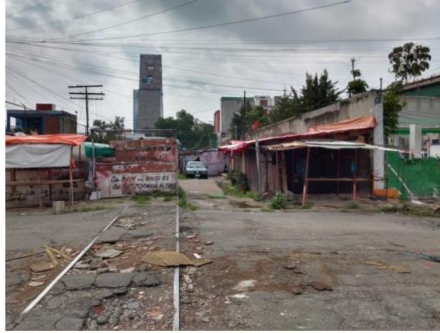
Ilustración 43 Asentamientos en vías del tren Calle Crisantema
