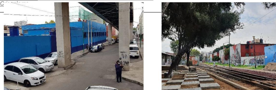
Ilustración 97 Bajopuente calle Pino y vías de ferrocarril calle
